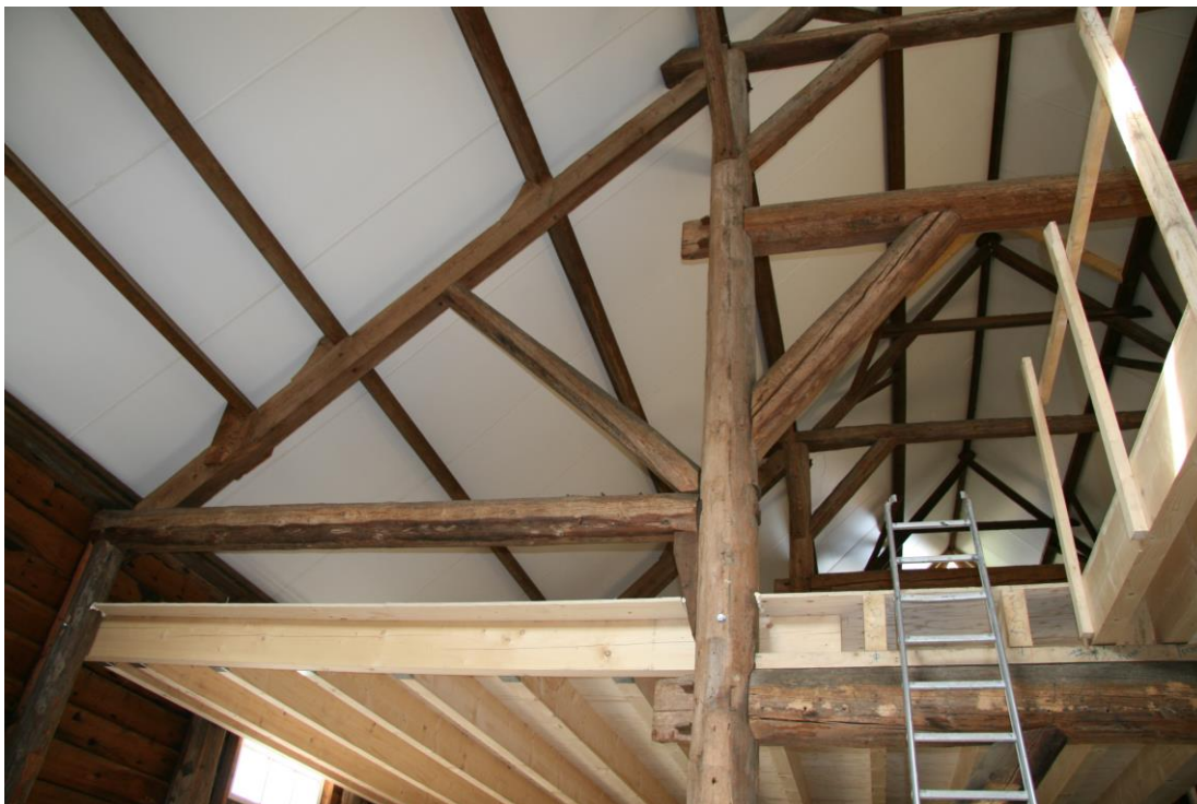
Het dubbele ankerbalkgebint in de linker zijbeuk (foto H. Gietema)
